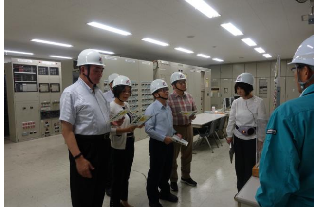
廣島電力所控制室
