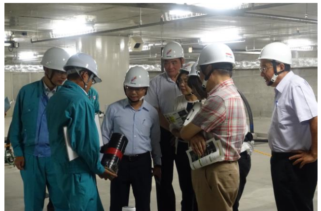
廣島電力所特高壓電纜現勘
