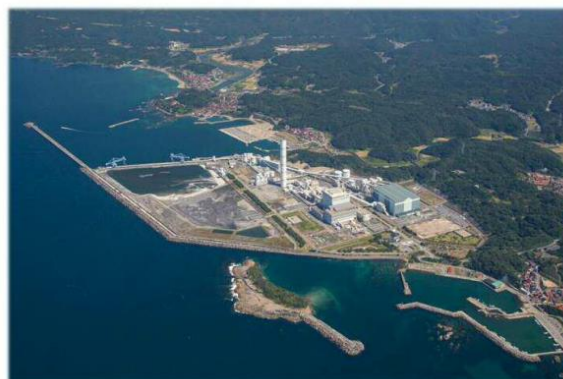
圖 9 三隅發電廠 2 號機
