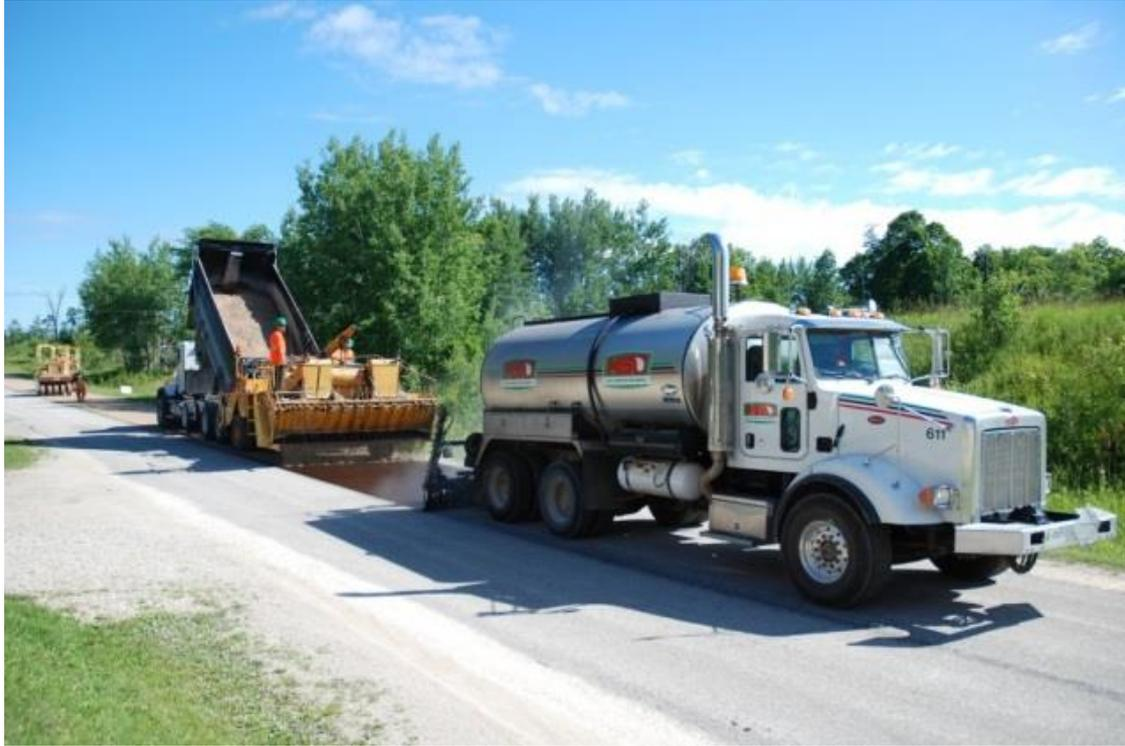
圖 3.4.2 灑布作業圖(圖資來源：PPRA 網站)
