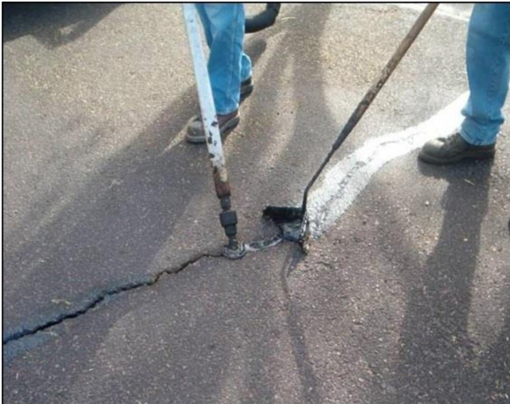
圖 3.1.1 填封作業圖(圖資來源：PPRA 網站)
