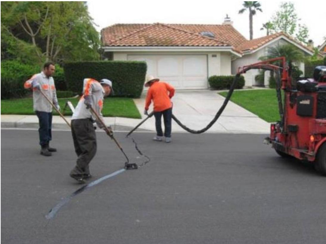
圖 3.1.2 填封施工圖(圖資來源：PPRA 網站)
