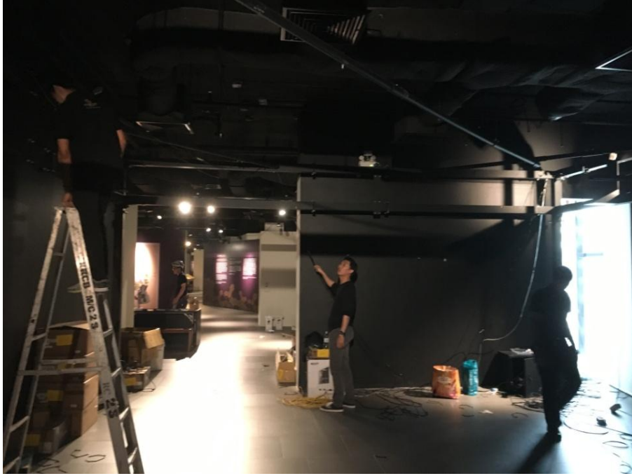
圖 7：「海錯奇珍－沉浸式互動劇場」大型新媒體裝置之拆卸作業。
