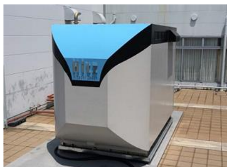
圖 13 日立造船株式會社 20 kW SOFC 發電機組與規格。 (Reference: https://www.ngkntk.co.jp/english/news/detail/001449.html )
