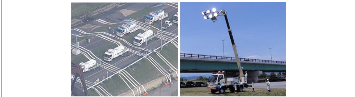
抽水中及照明車操作實績
