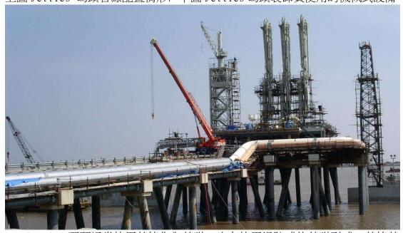
Jetties碼頭通常使用基樁作為基礎,也有使用堤防式的基礎形式;基樁基礎的施工優點,是基樁的製造在工廠內,品質及時間的控管相對容易,但是營建材料成本會比較高,設計條件也比較嚴峻(基樁的耐壓/承載試驗);而堤防式基礎成本可能比較低,但是回填的土方必須經過夯實、壓密,逐層回填等程序,因此耗時會比較久,對於想要快速營運回收成本的考量的話,可能要做好營建時間的控管。
