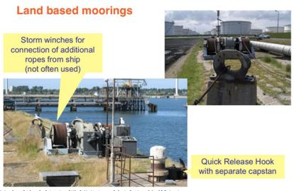
絞盤幫助拉緊繫船繩,快速脫鉤裝置
