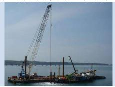
水上吊車(Marine Cranes) 使用限制: 承載<100 T 使用期限受限於波浪狀況 因所有權利影響使用成本 水深限制航道 有船身浮動影響工作性
