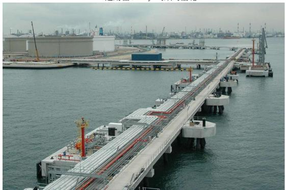
上圖 Jetties 碼頭管線配置情形/下圖 Jetties 碼頭裝卸貨使用的機械式設備
