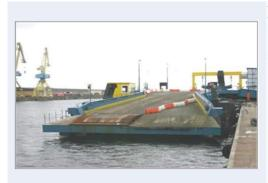
Floating pontoon system 潮位變化較大,無法直接卸載 裝置承載力,轉換角度受限制
