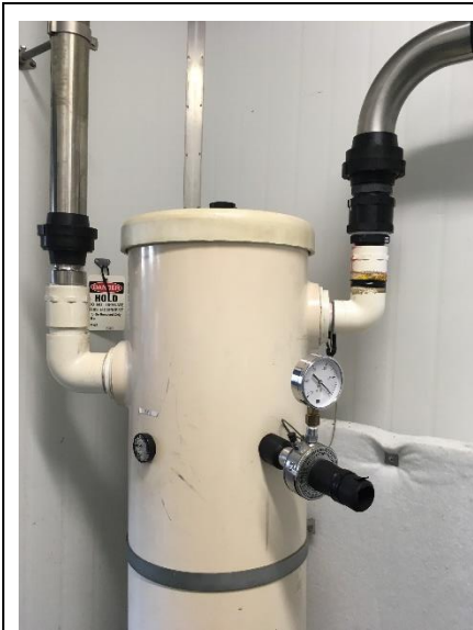
圖 13.空氣流量計與真空計裝設於分配桶上測量
