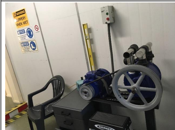
圖 15.利用滑輪直徑計算真空馬達轉速
