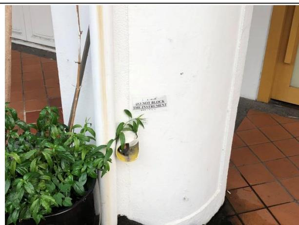
圖 32、歷史建築樓柱裝設監測用稜鏡
