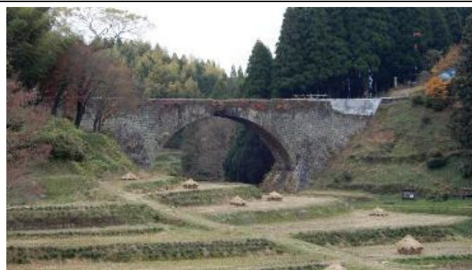
圖31 本次現勘通潤橋現況
