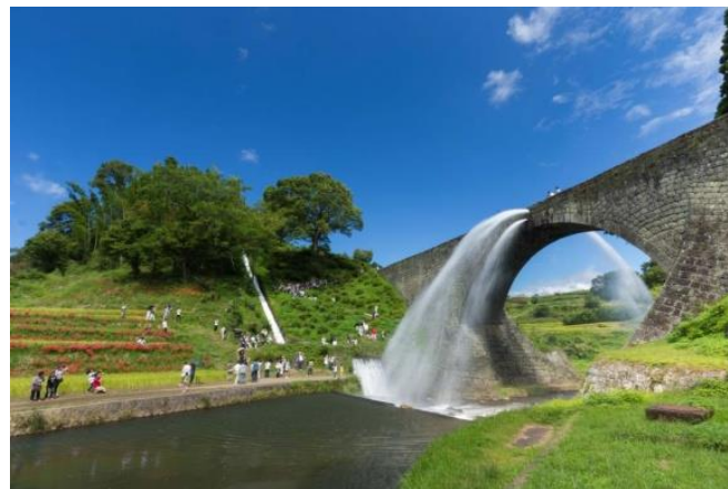
圖30 通潤橋放水照片
