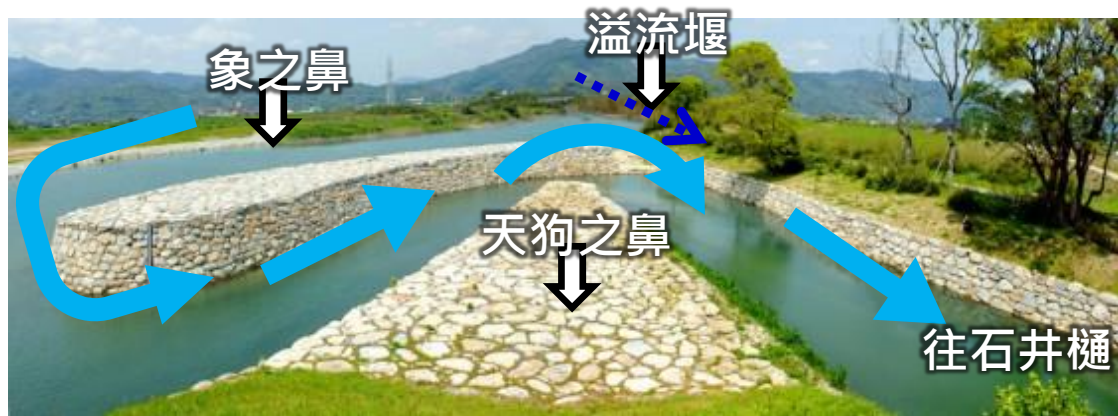
圖7 石井樋設施取水流路示意圖
