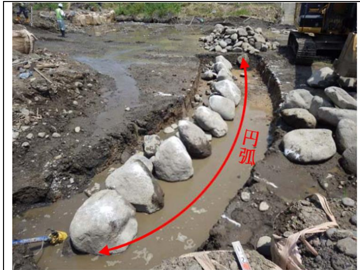
圖45 瀨潭拱形壩施工方式
