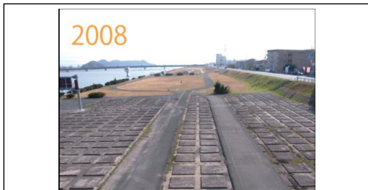
圖19 遠賀川魚道公園改善前照片(2008年)
