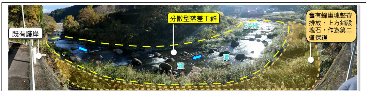
圖62 赤石川分散型落差工兼具水域多樣性及河防安全
