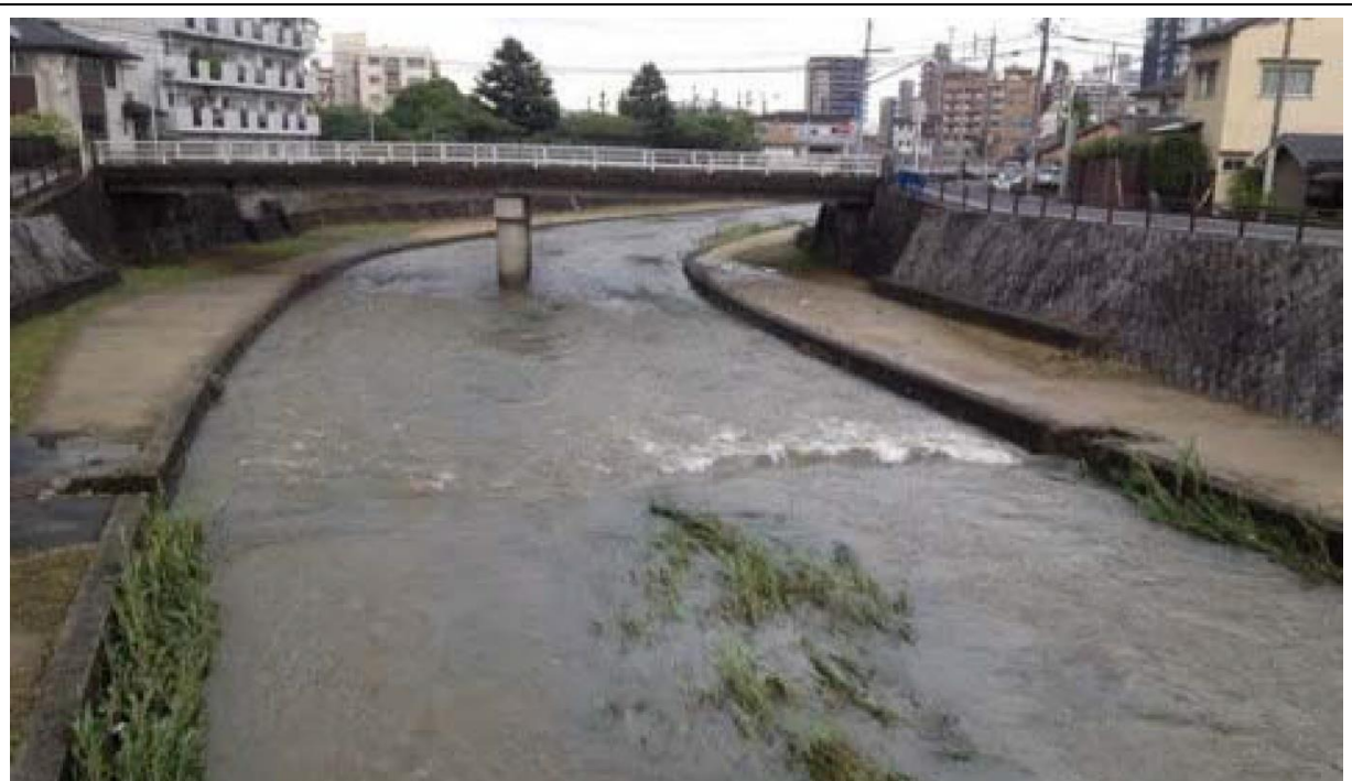
圖25 施工前河道狹窄
