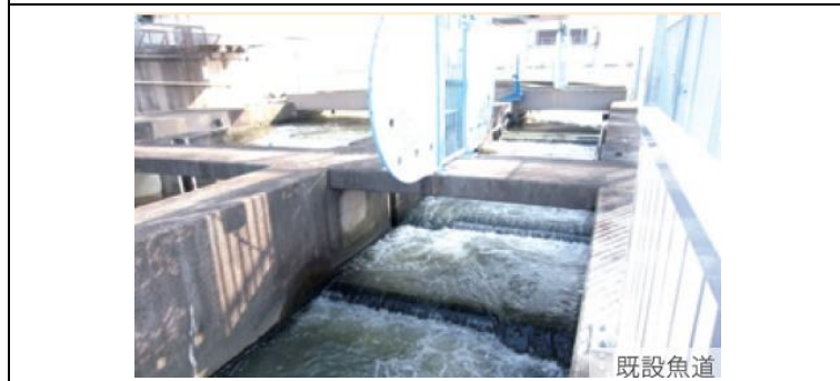
圖20 遠賀川河口堰既設階梯式魚道
