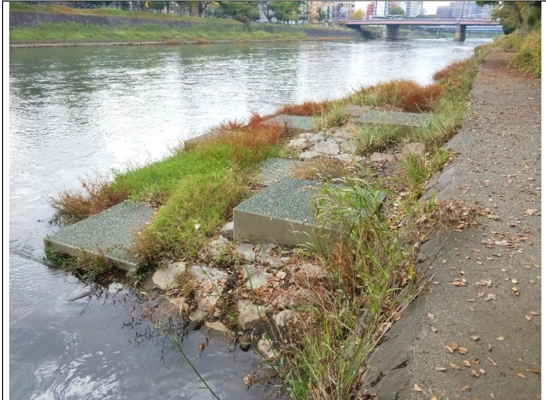
圖66 白川以混凝土方塊搭配混砌塊石營造不同水域流況
