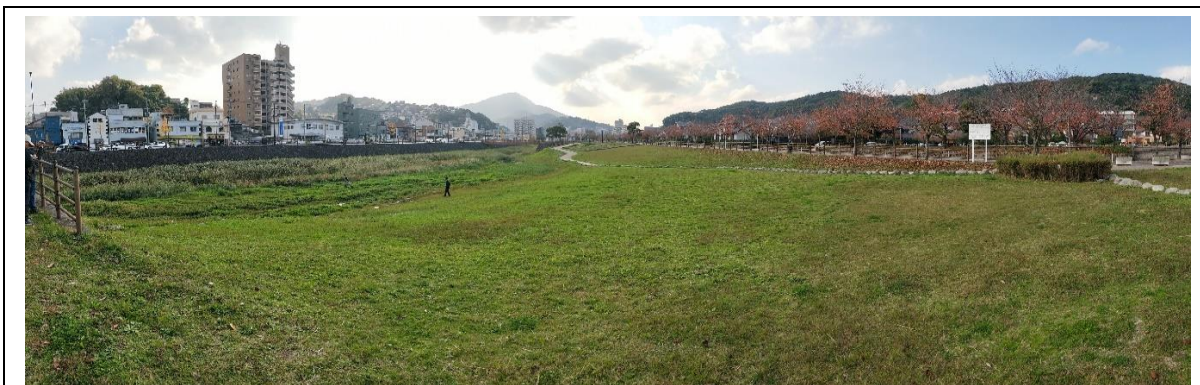
圖27 拓寬河道3倍完工後現況
