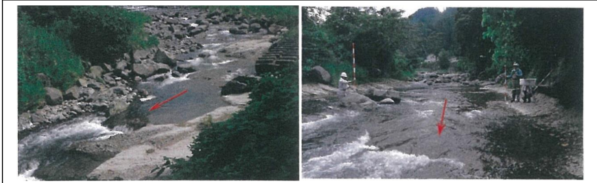
圖61 赤石川護岸前方河床下切泥岩裸露
