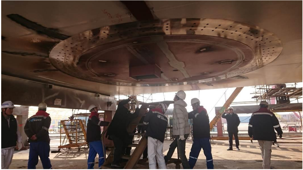
鋼橋軸承位置檢視
