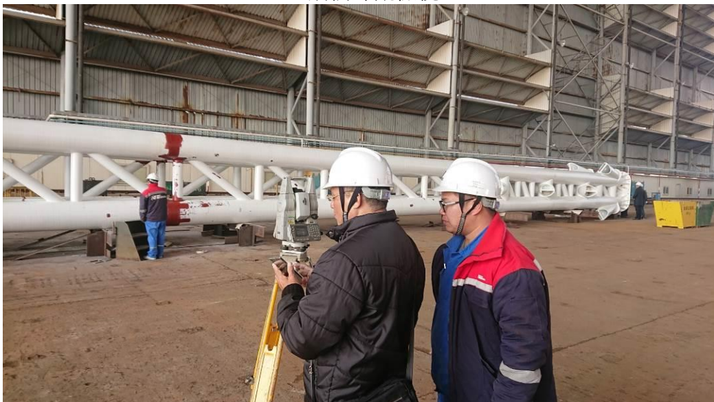
監造單位--鋼橋橋塔長度量測
