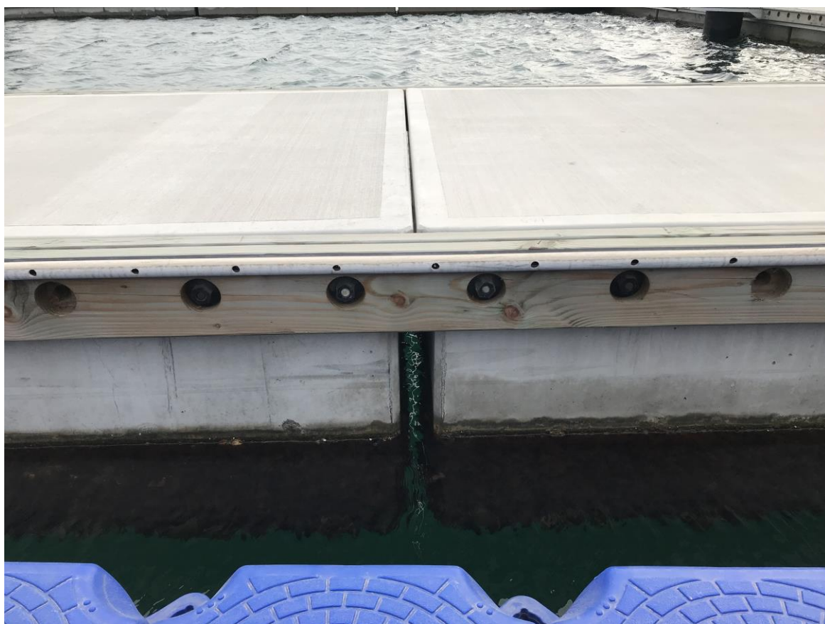
混凝土浮箱固定構件
