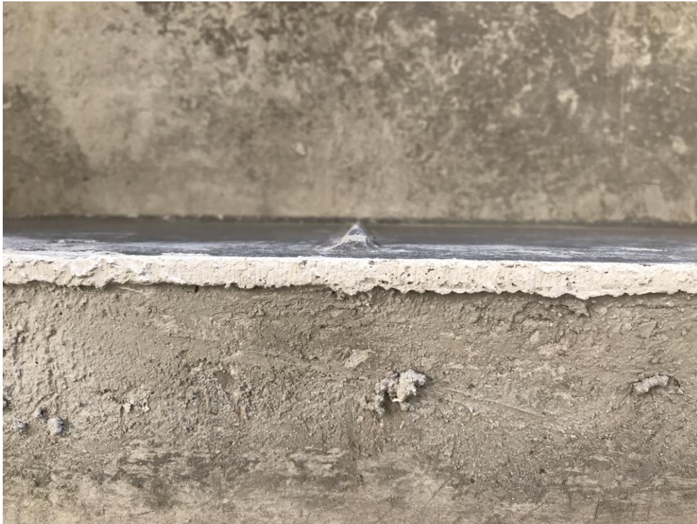
鋼模具於固定間距留設伸縮縫砌角
