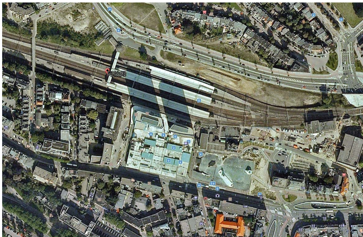
圖 5-1.4：2005 施工初期的空拍照片
