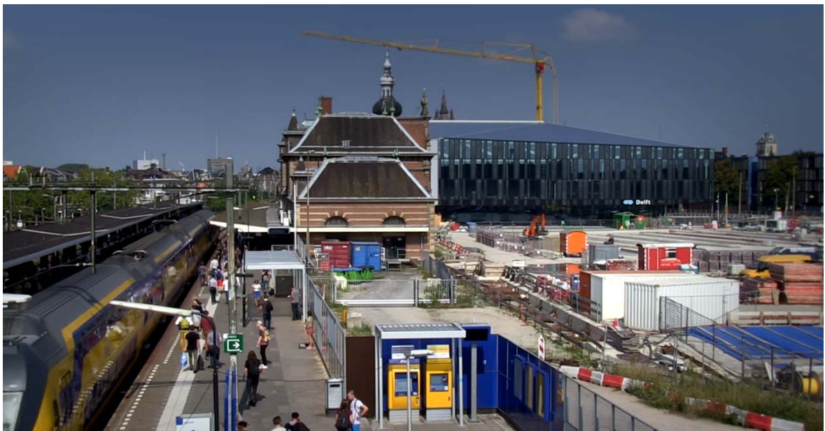
圖 3-1.4：台夫特車站內部裝修與地面站體施工照片(資料來源：麥肯諾事務所網站)
