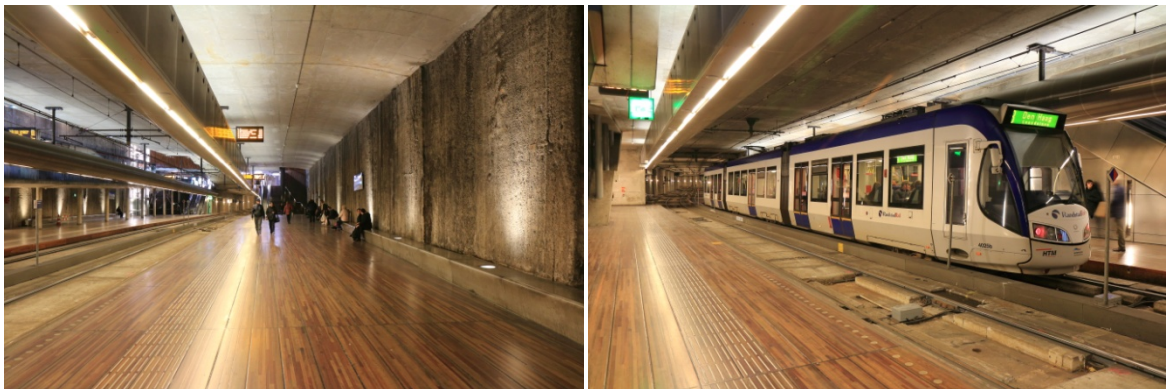
圖 3-2.8 木質地板與粗糙的混凝土牆面
