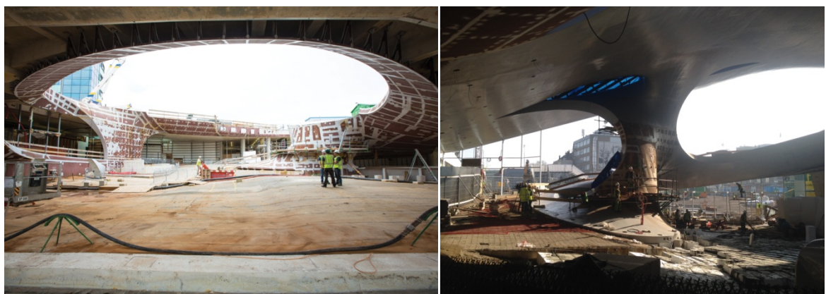
圖 5-1.3：阿納姆中央車站將造船技術應用於弧形的鋼板建築體上
