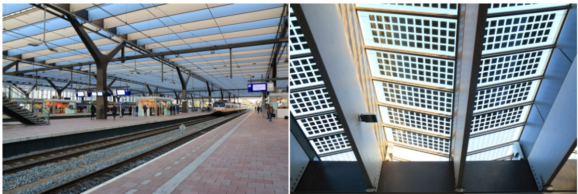
圖 3-1.10 月台採光屋頂結合太陽能板的設計
