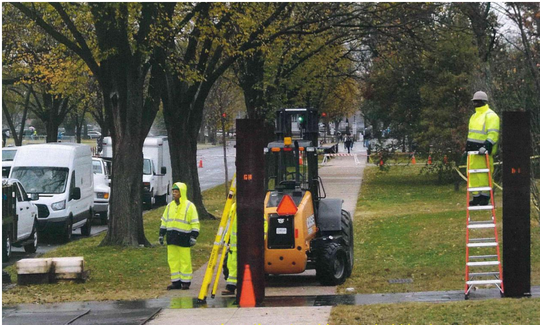
防洪路閘施作情形 (資料來源:美國工兵團)
