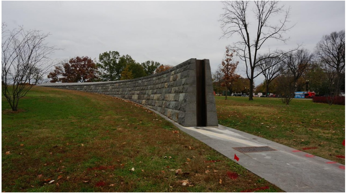
路閘兩側固定牆
