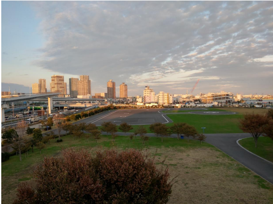
圖 15 東京臨海廣域防災公園多功能廣場及停機坪
