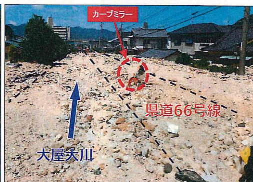
被災後状況写真
