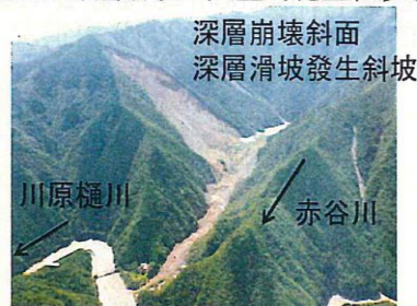
写真. 崩壊地と下流への土砂流出(災害直後) 照片. 滑坡和下流的泥土和沙子排出(立即在災難發生後)
