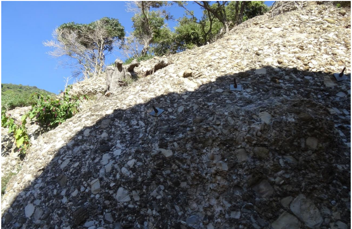
照片 8 San Fruttuoso 修道院附近利用岩栓工法來減少沖刷
