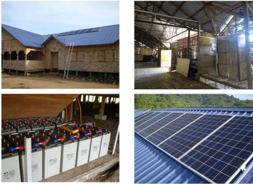
圖 8、馬來西亞彭亨州離網太陽能光伏系統之安裝
