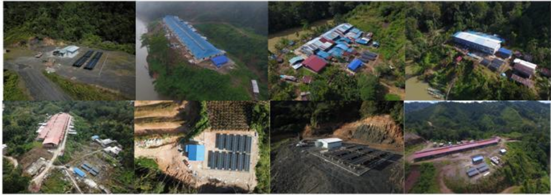
圖 9、馬來西亞沙勞越農村電氣化替泰計畫完成的航拍圖
