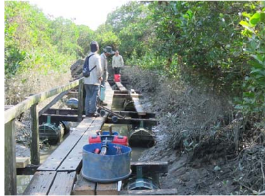
工人修築浮橋
