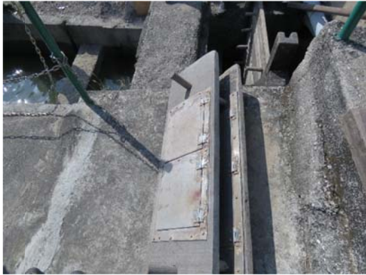
傳統基圍檔板之閘板
