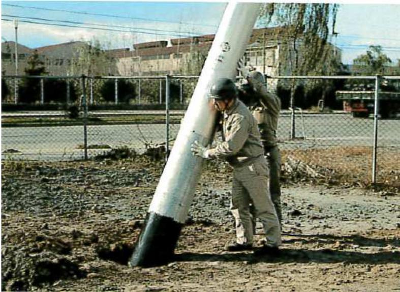
圖七-套裝式鋼管柱的架設
