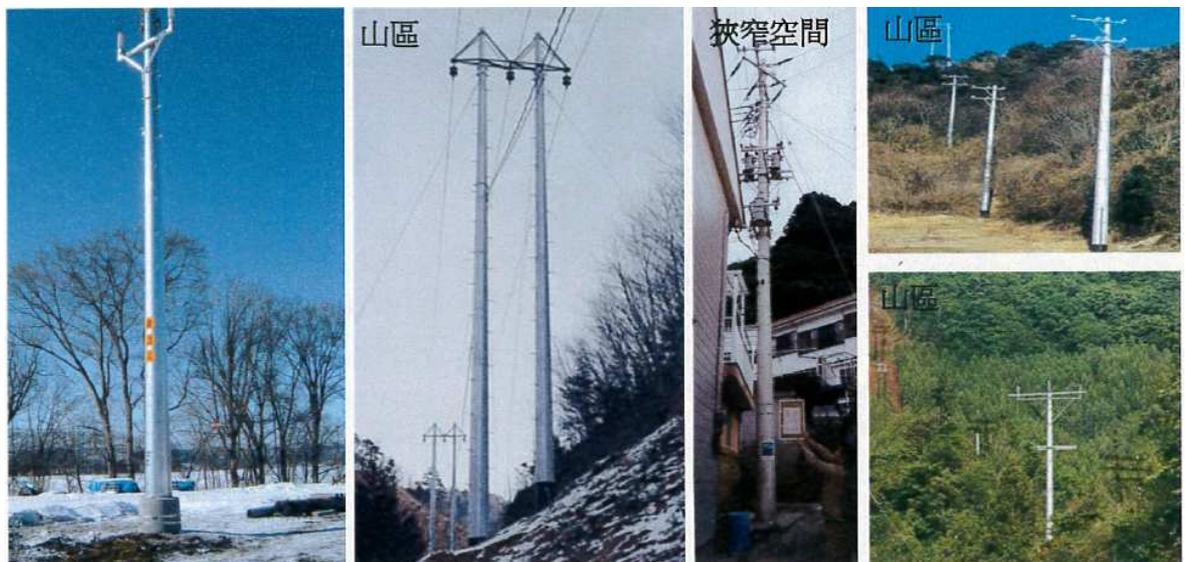
圖六-套裝式鋼管柱於輸配電線路電桿的應用實例
