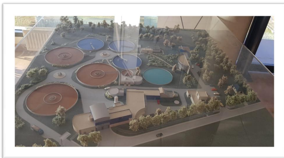
圖 13 繆羅市污水處理廠處理單元佈設圖
