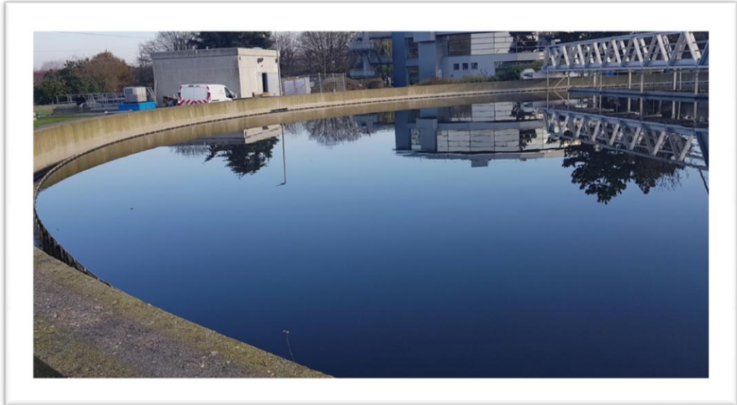
圖 15 繆羅市污水處理廠終沉池照片
