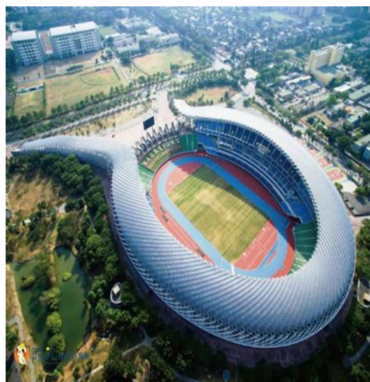
圖 12 高雄市政府在高雄世運會主場館的屋頂，共設置 8,800 片太陽能光電板，每年發電量達 110 萬度。(圖片來源：中央社)
