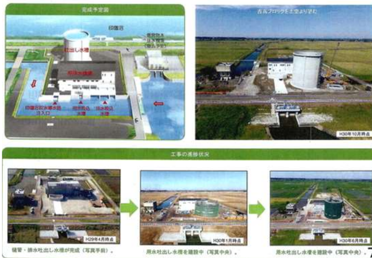
圖 3-19 吉高抽水站施工狀況一覽
