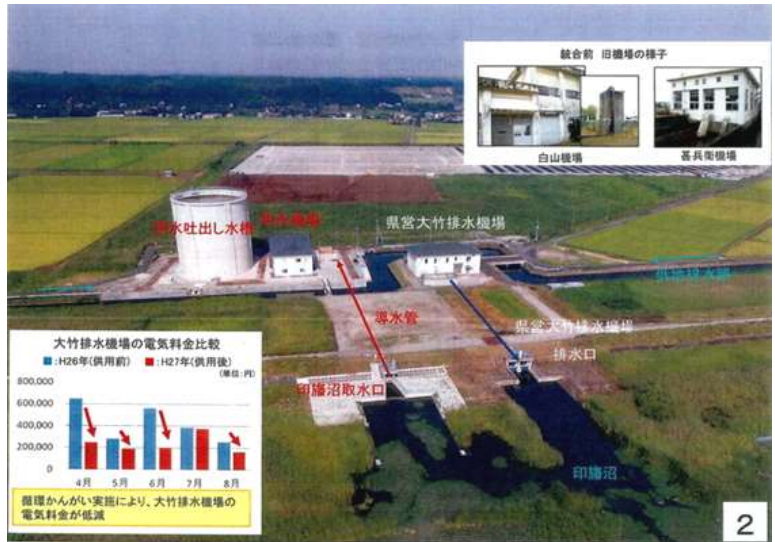
圖 3-16 白山甚兵衛抽水站(平成 27 年啟用)
