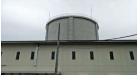
A.蓄水(出水)槽
