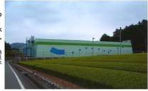
金谷吐出水槽全景
