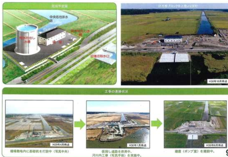
圖 3-20 宗吾抽水站施工狀況一覽
