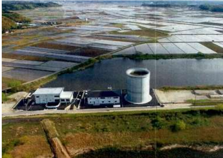
圖 3-26 新設抽水站啟用引進印旛沼水源進入乾旱地區(空拍圖)
