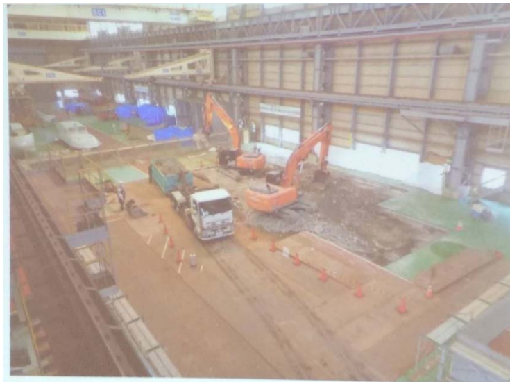
埠頭工廠正在進行5.2MW風機生產線之改建， 包含地面承載力加強，增設大型吊車等。
