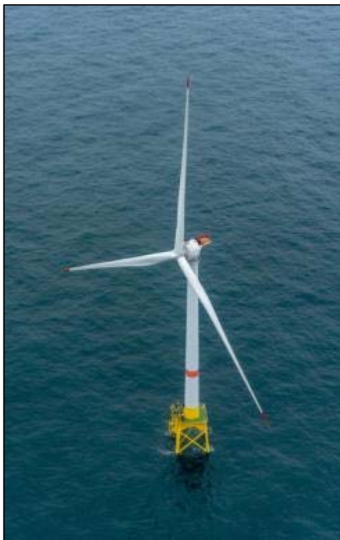
示範機組 GE 6MW 2013年安裝完成 型號：Haliade 150 水下基礎為jacket型式 (Alstom Haliade Demonstration 6MW WTG)
