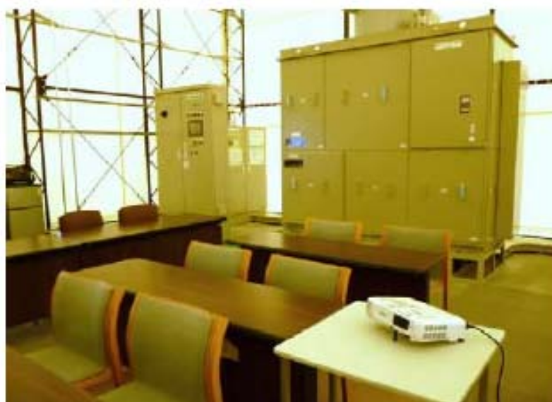
左後方為控制盤、右後方為電力控制系統（PCS）
