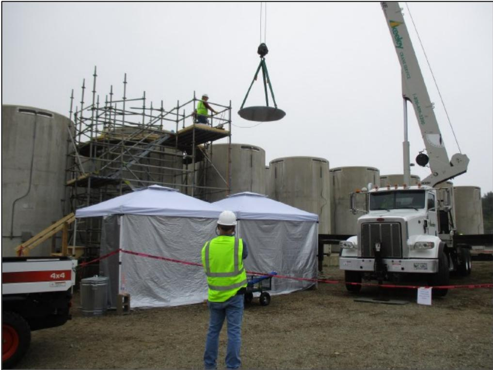
圖2-3-2-6-1進行搭架、及吊走上方混凝土頂蓋
