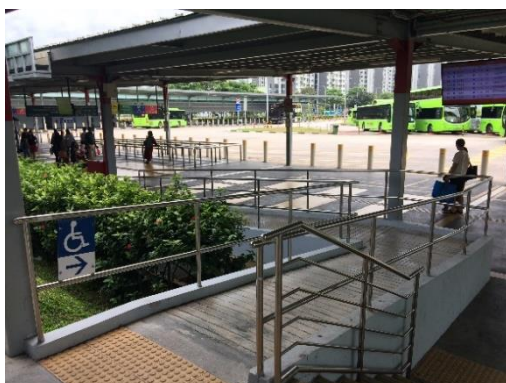
圖 48 無障礙斜坡走道
