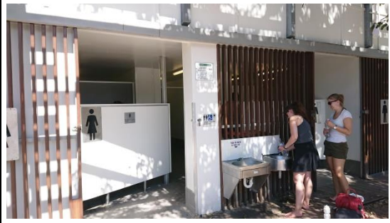
圖 80:無障礙淋浴間及廁所
