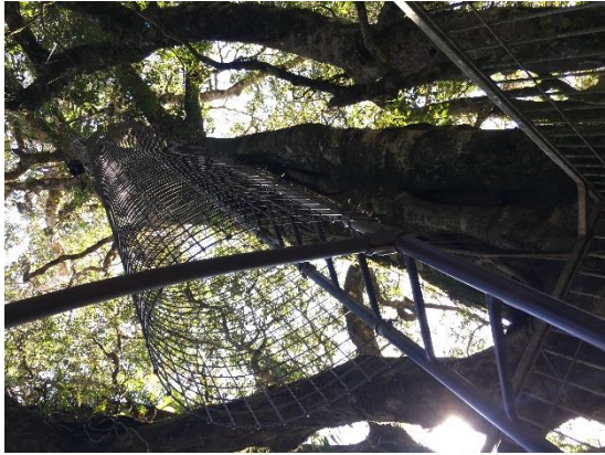
圖 29: 雨林區中鋼構的高架步道(Treetop Walk) 樓梯周邊用鋼構網架保護遊客安全
