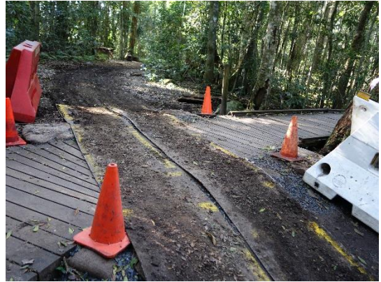
圖 30: 雨林區步道施工時保護木棧道機制及安全措施
