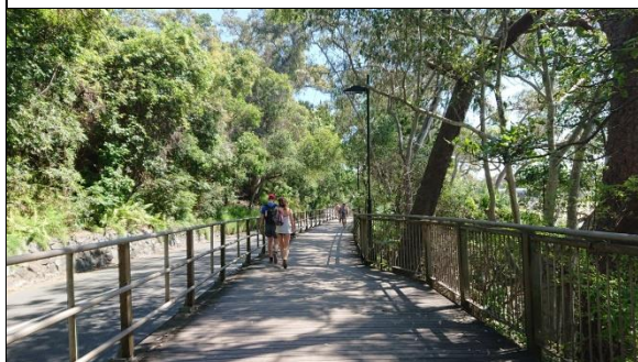
圖 77:周邊人行步道，設置落實人車分道
