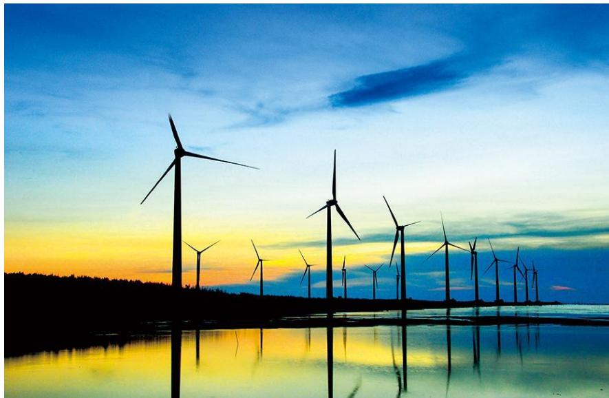
圖 5 台電台中港風力發電站
