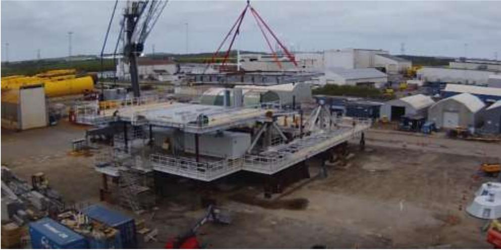
圖 20 變電設備平台結構組立
