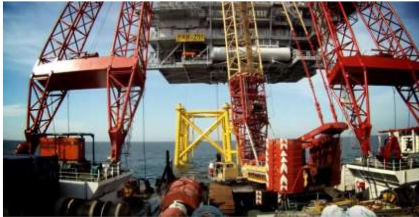
圖 30 變電設備平台與套筒式基礎接合
