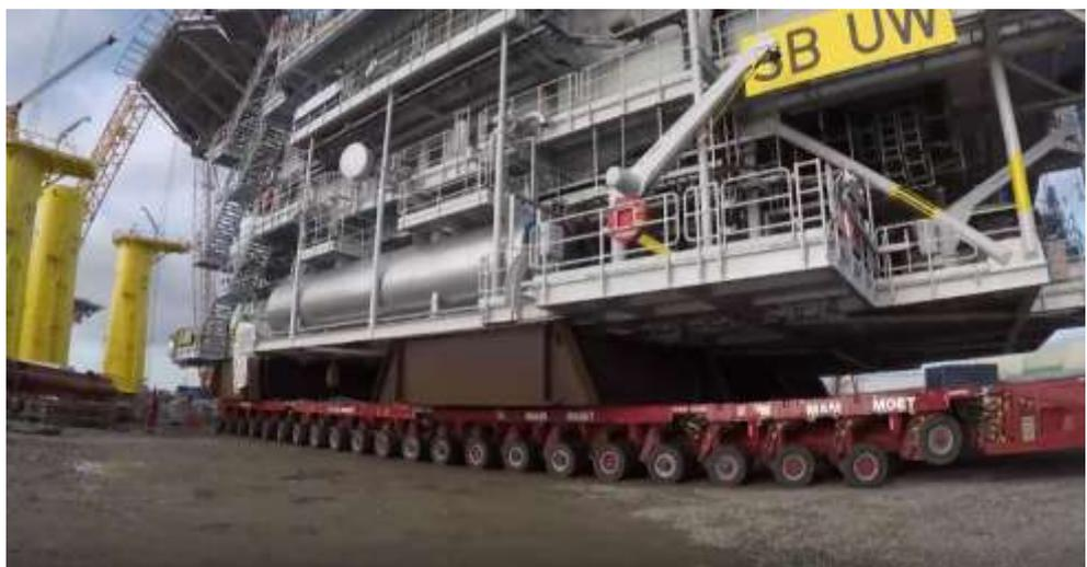
圖 22 變電設備平台移動
