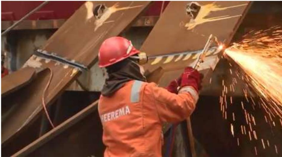
圖 24 套筒式基礎固定端切除
