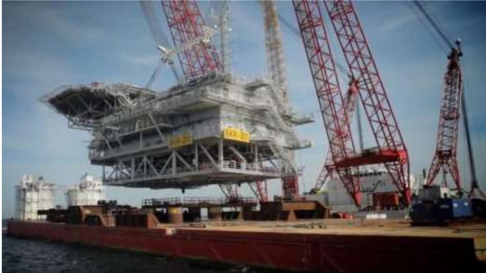
圖 23 變電設備平台吊放至拖曳船
