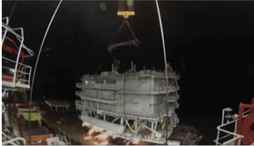
圖 29 變電設備平台固定端切除
