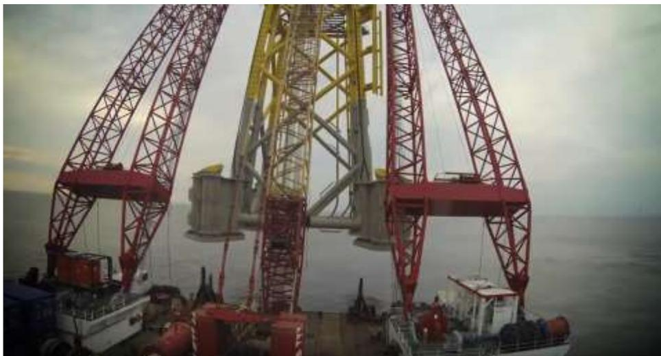
圖 25 套筒式基礎吊離拖曳船
