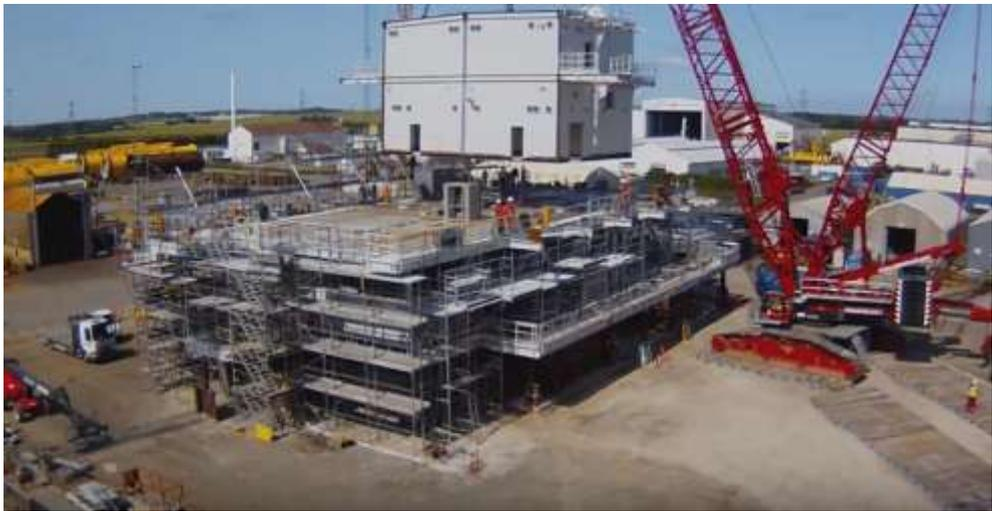
圖 21 變電設備平台設備安裝
