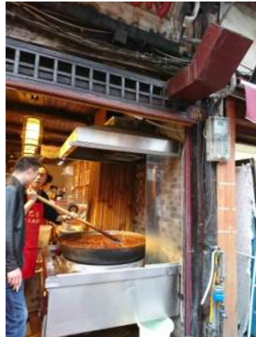
重慶沙坪壩區參訪逸散源空氣污染防制 -餐飲業廢氣收集排放
