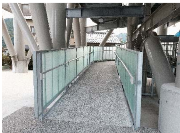
避難塔設置殘障坡道
