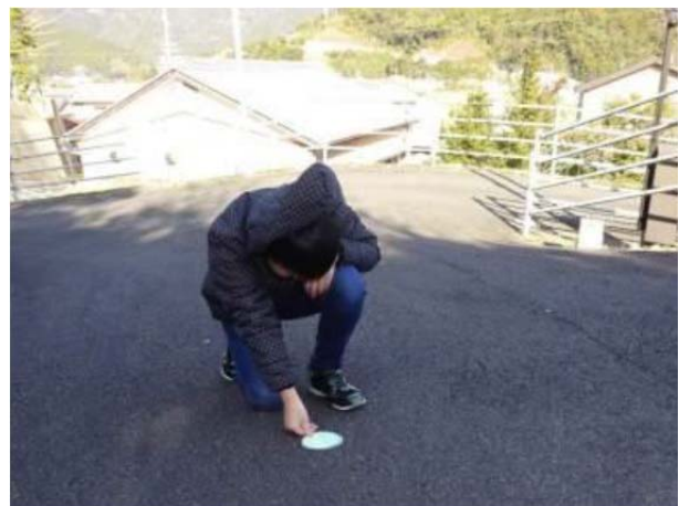
避難道路上設置夜光裝置
