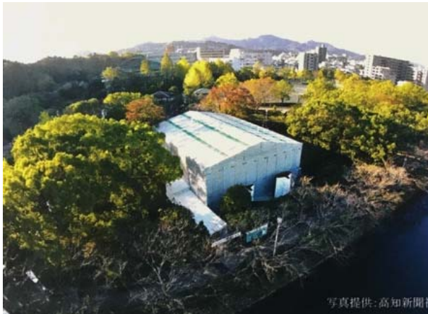
簡易屋頂 TRUSS
