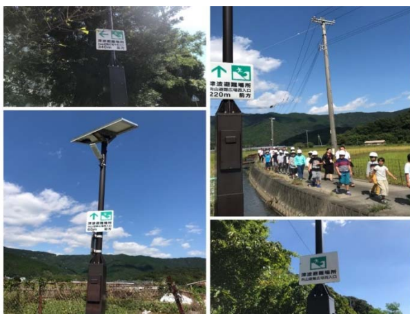
避難道路上設置太陽能發電路燈
