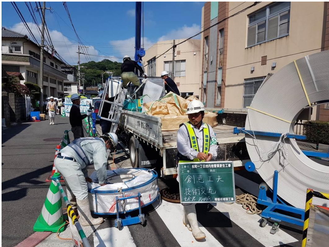
圖 39 管線修復施工
