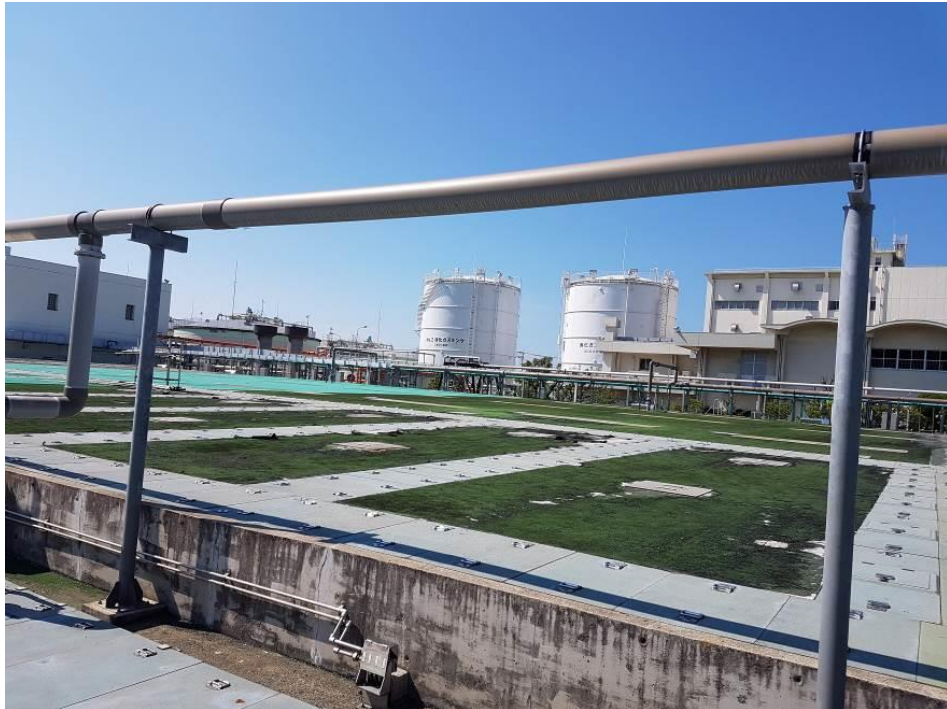
圖 5 福岡中部水處理中心
