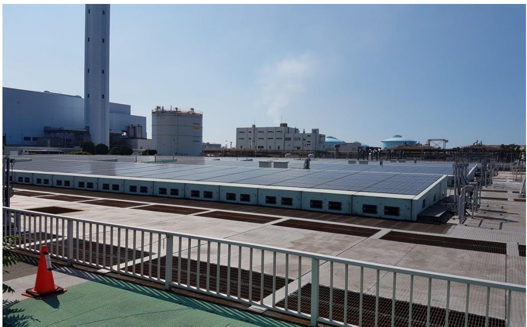
圖 7 太陽能發電設備
