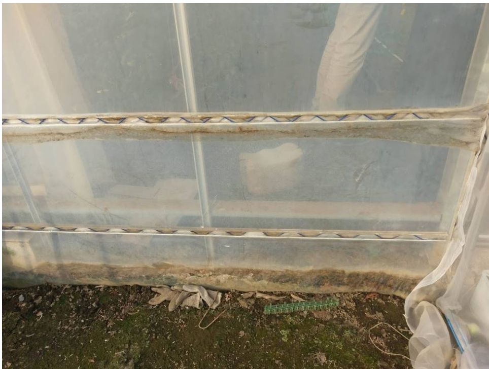
圖 26.溫室與地面接合住以土層壓實防止間隙產生。
