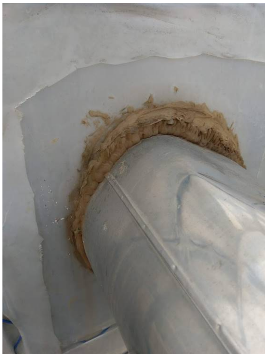
圖 28.採用泡棉膠密封管線與溫室間隙縫。
