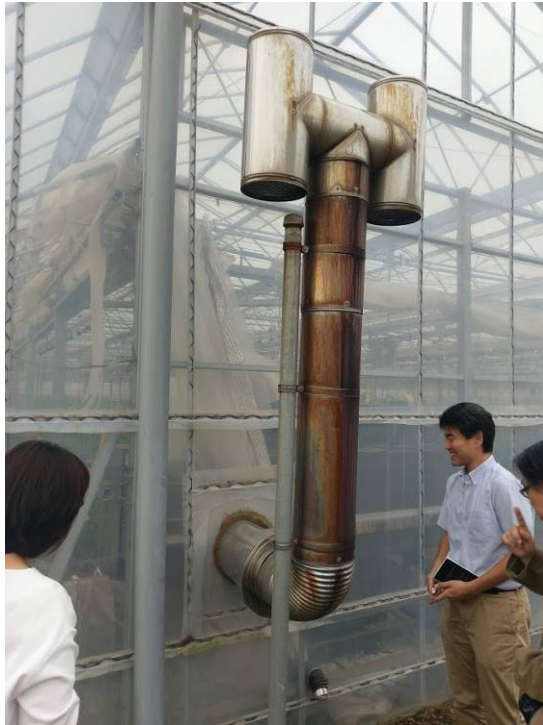
圖 27.柴油溫室加熱器之排氣管於溫室出口處密封。
