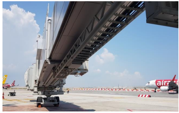
樟宜機場第四航廈使用中之空橋設備(二)
