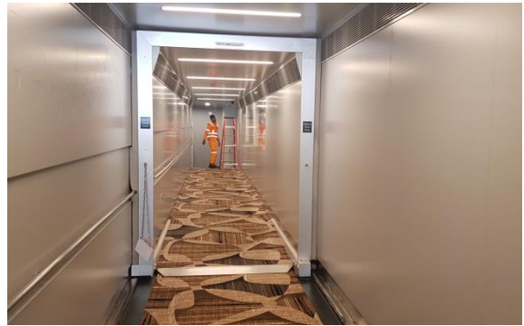
空橋伸縮走道
