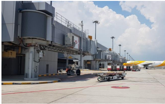
樟宜機場第四航廈使用中之空橋設備(三)
