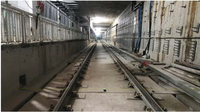
T203及T205車站軌床施工完成
