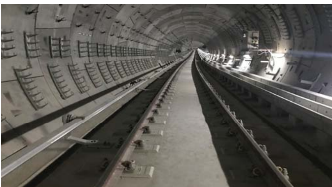
Mainline-T206-WB軌道施工完成並交付給業主
