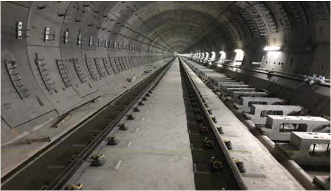
T206軌床完成walkway施工中
