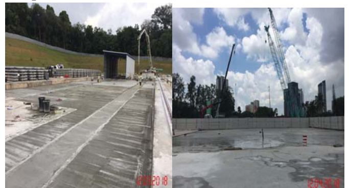
T208及T215 TSA 施工完成
