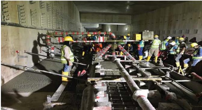
T206 道岔區施工中
