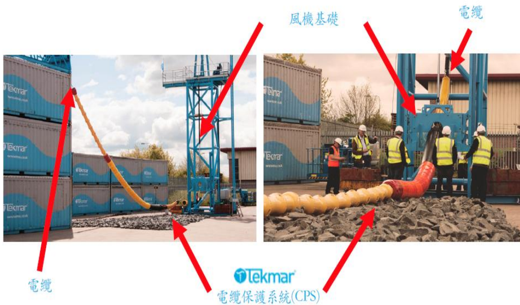
圖 21 Tekmar 電纜保護系統施工
