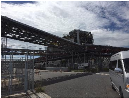
第 7B 號爐入口
