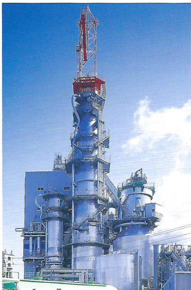
5KP設備 5KP plant
