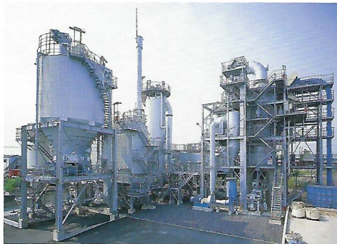
流動床焼却炉設備 能力 80BDT/D (2002年稼動) Fluid-bed incineration equipment 80BDT/D (operational from 2002)
