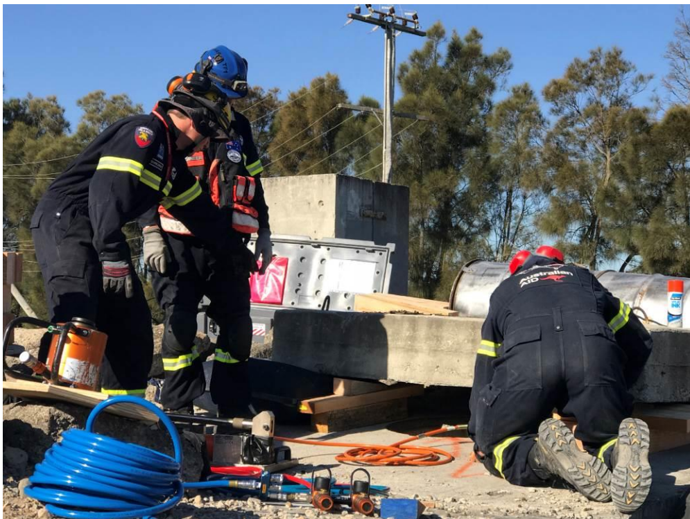
圖 33：大型重物抬昇以便進入搜救
