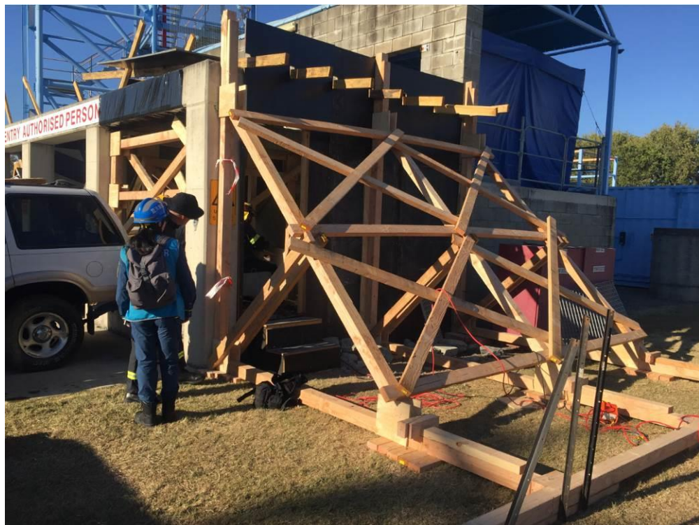
圖 31：對於有倒塌疑慮之建築物進行支撐作業
