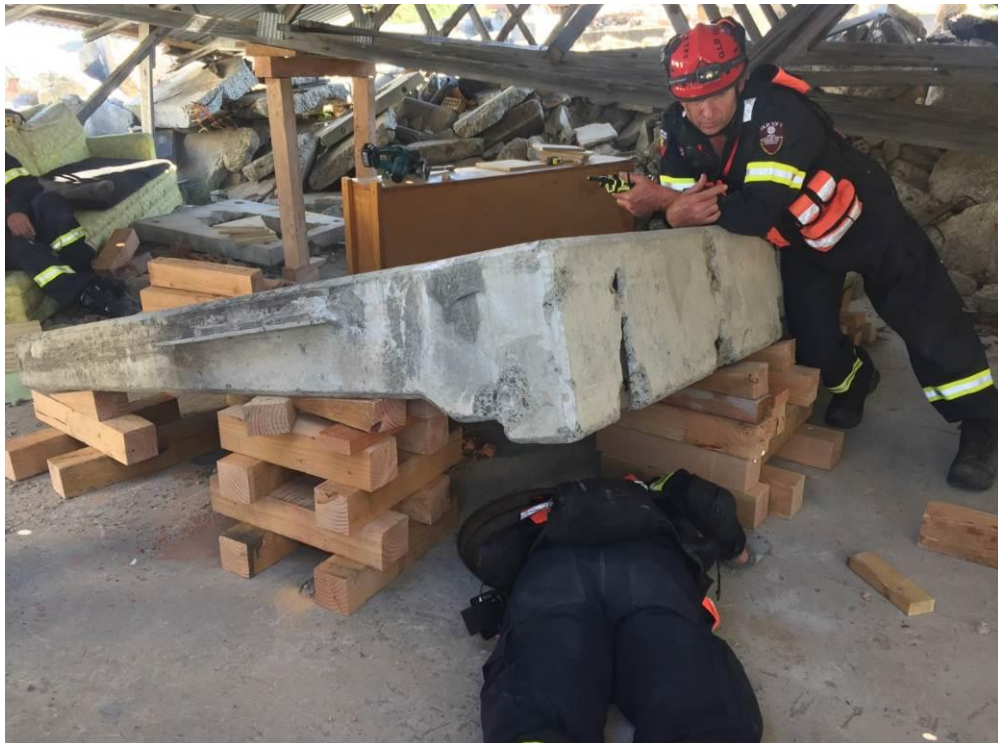
圖 37：重物抬昇後人員進入搶救
