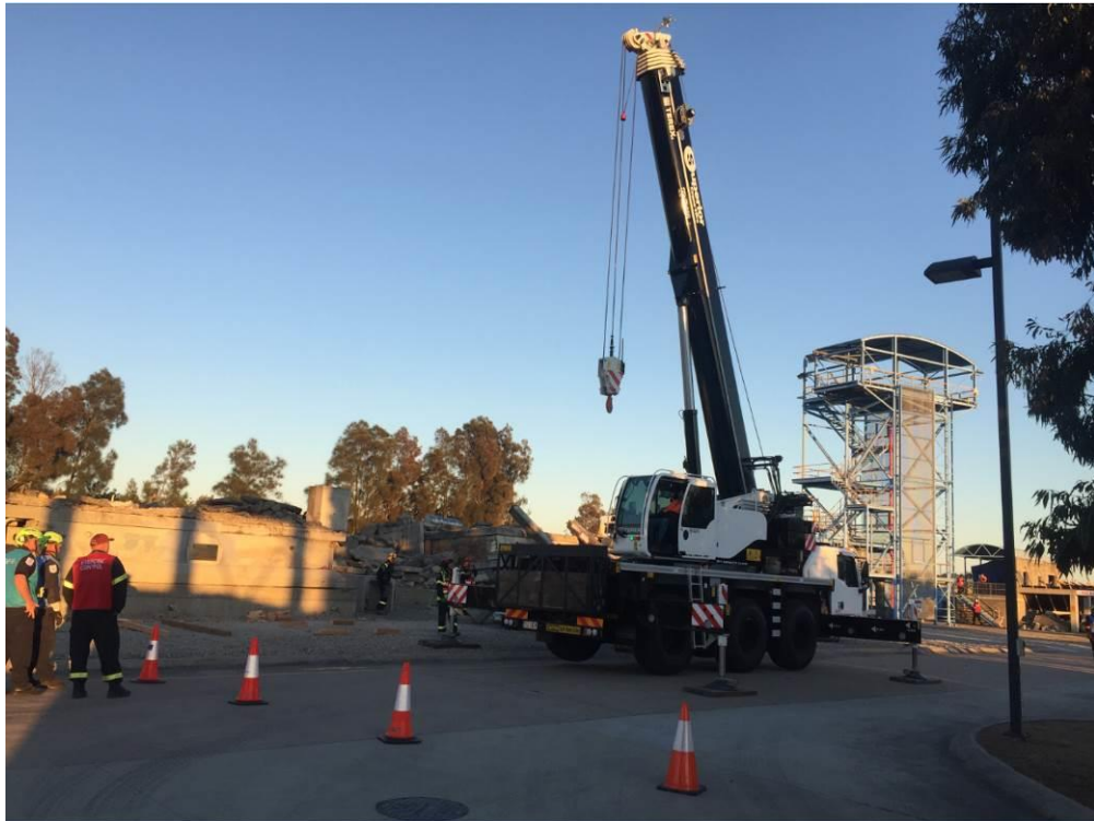
圖 28：與民間吊車公司配合進行重物移除作業
