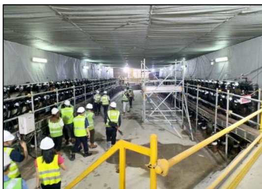
施工中之人行通道冷凍管道布設實況
