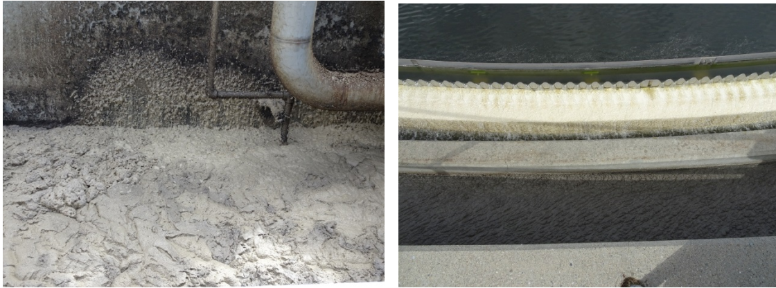
圖3.4-4 廢水二級處理
