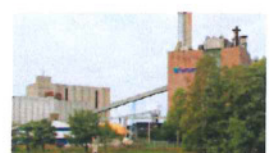
TSE Naantali SCR retrofit
