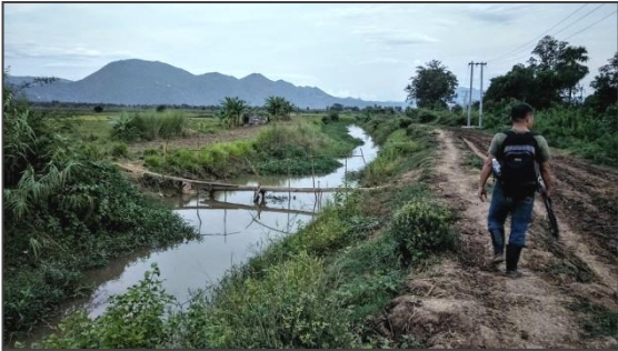
圖 81、溝渠、土堤和堤頂小徑
