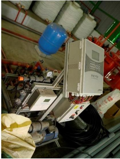
圖 39、在養液輸出配製時也有電腦負責控制 7 個養液桶的出水量
