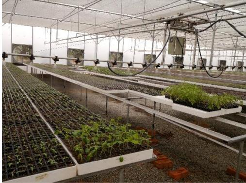
圖 41、水牆降溫溫室內有自動灌溉設備
