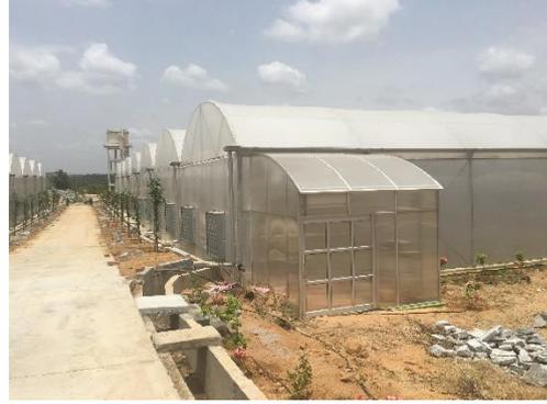
圖 40、19 棟兩千平方米的水牆降溫溫室分為左右兩側一字排開。
