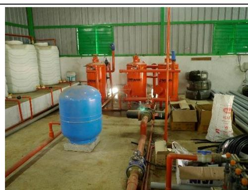
圖 38、溫室旁的的倉庫有肥料、養液桶及輸送管路。
