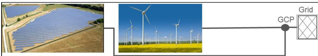
圖 45、產生電能的發電系統 (Power Generating System, PGU) 照片 29
