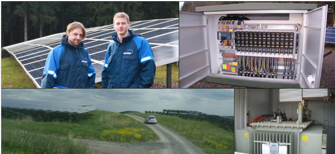
圖 52、TÜV NORD 太陽光電電站現場查核照片 36
