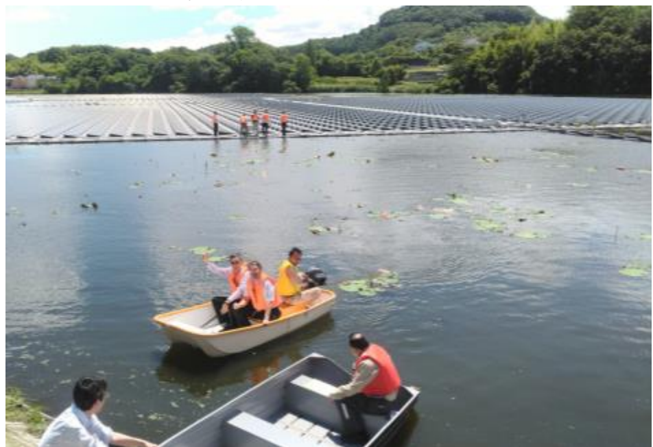
圖 14：參訪平木尾池水上太陽光發電所-2
