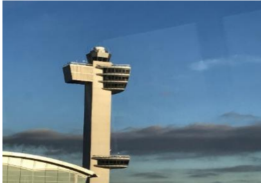
JFK 塔台(上層)與機坪管制台(下層)
