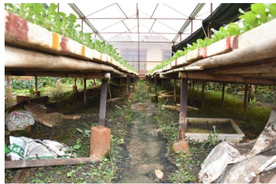
常見苗床腳架鏽蝕後以水泥補強
