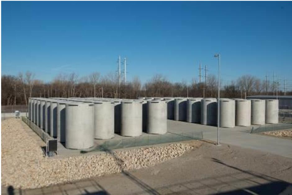
圖 3.2.2 用過核子燃料乾式儲存系統
