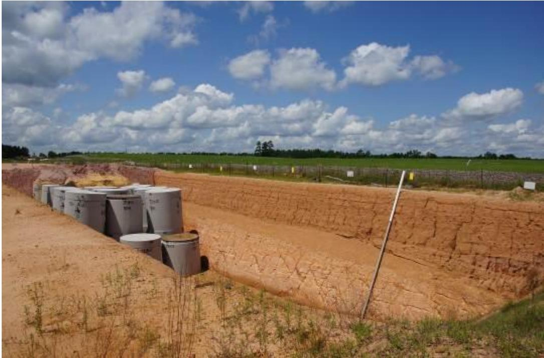
圖 3.4.5 廢棄物處置壕溝(trench)示意圖
