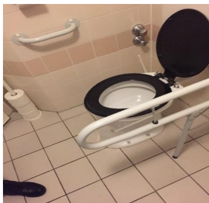
圖十七 浴廁於障礙設施
