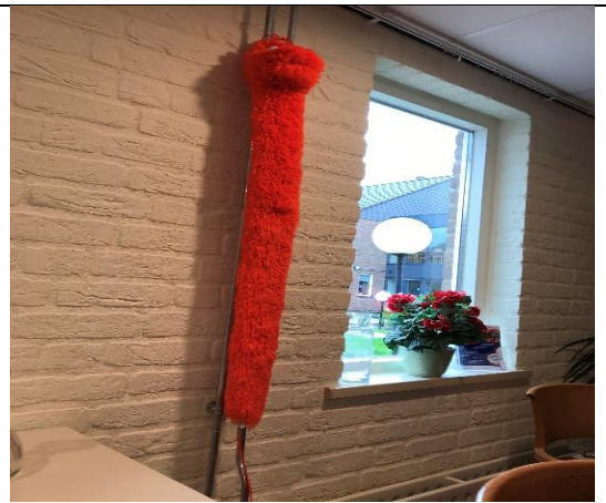
圖七 中央空調供氣管路，預防住民熱燙傷，給予保護套。
