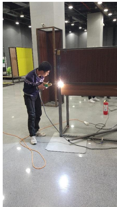
鐵件展件點焊加固
