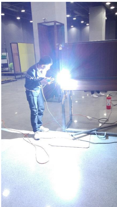
鐵件展件點焊加固
