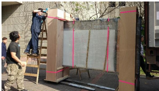
固定柱過高現場切除
