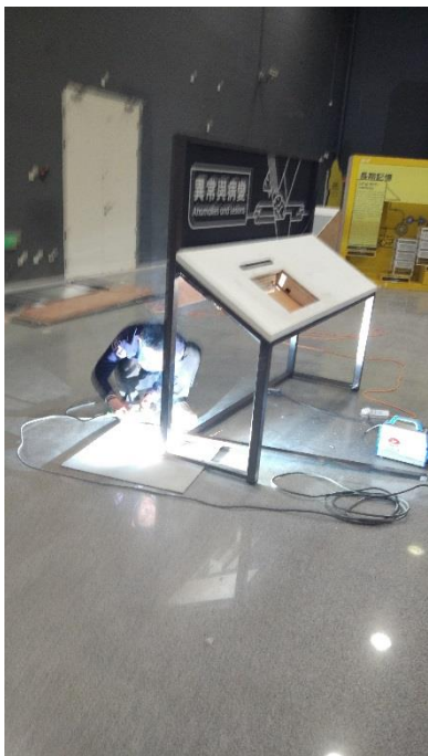
鐵件展件點焊加固
