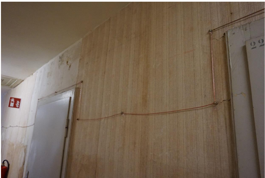
(「賀恩玄浩森」前東德秘密警察監獄紀念館牆壁上的通電線，只要有緊急狀況，就可以扯斷，通知全館緊戒)
