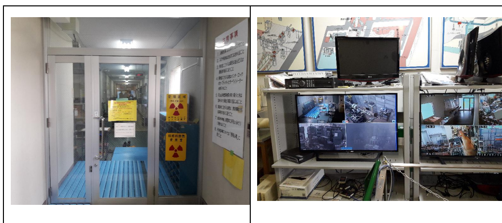
圖 28 （左）輻射管制區入口與（右）監視錄影系統
